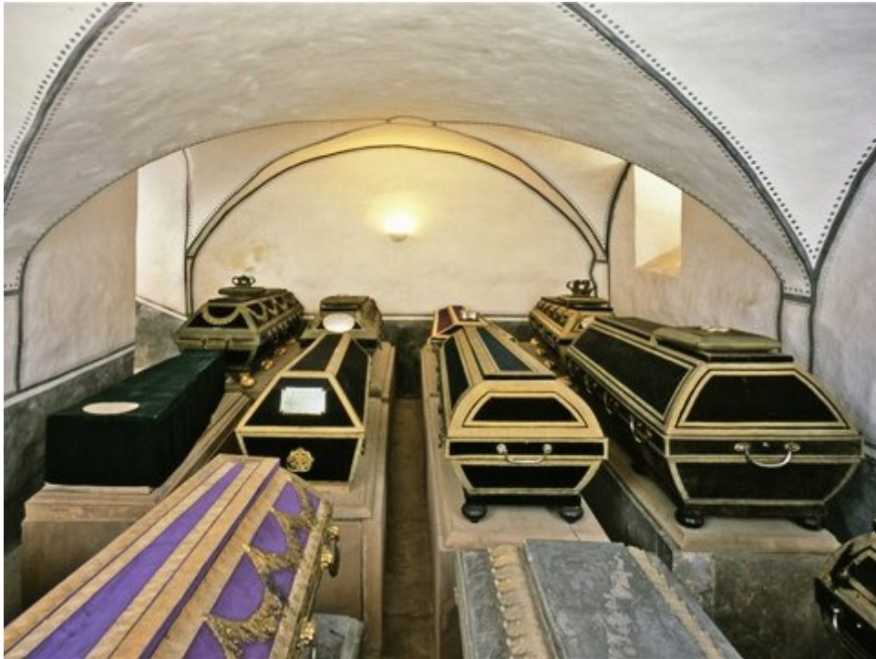
Die sanierte Grablege des Hauses Baden in der Südgruft der Schloßkirche. Foto: Amt Vermögen und Bau (Altenkirch)
